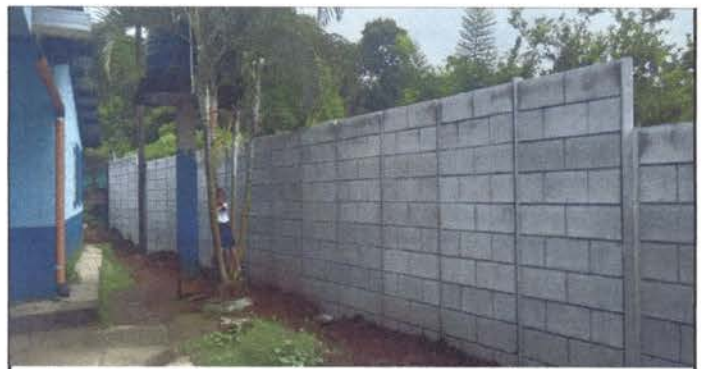
Foto 6: MÓDULO 4 MURO REPARACIÓN DE MUROS DE BLOCK
