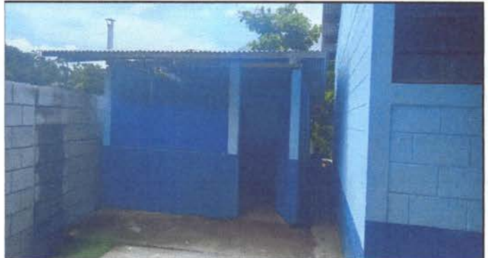
Foto 2: MÓDULO 1 COCINA SUSTITUCIÓN DE BALCÓN DE METAL -
