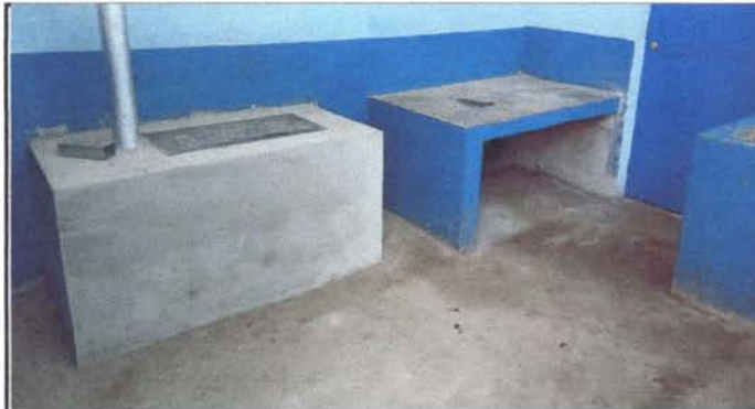
Foto 3: MÓDULO 1 COCINA SUSTITUCIÓN DE ESTUFA RURAL (COMPLETA) INCLUYE CHIMENEA Y PLANCHA DE METAL
